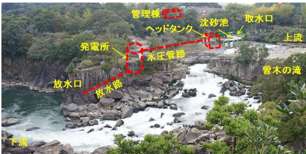
図 1. 新曾木発電所（曾木の滝右岸）
