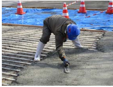
写真1 施工状況(1BL)
