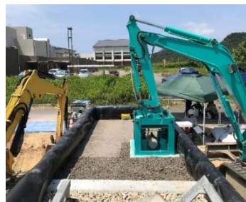
写真-1 固化体混練物の締固め
