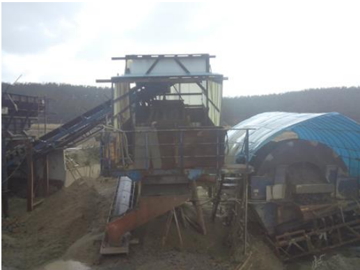
図1 砂洗浄機械による洗浄状況
