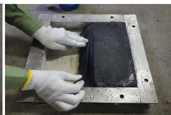
写真-5 シール施工
