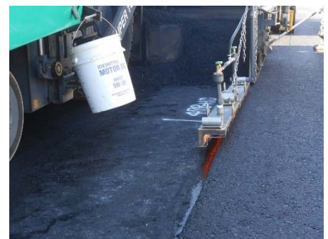
写真-1 アスコン打継目部施工例
