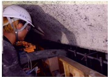
写真3 高流動コンクリート(L)打設
