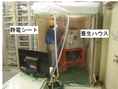
写真-2 施工状況(1階)
