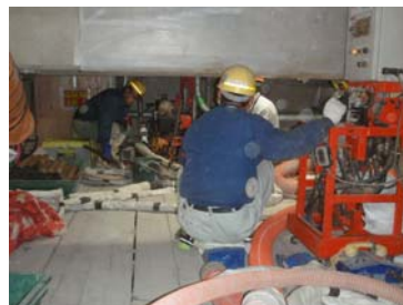
写真-4 施工状況(地下室)
