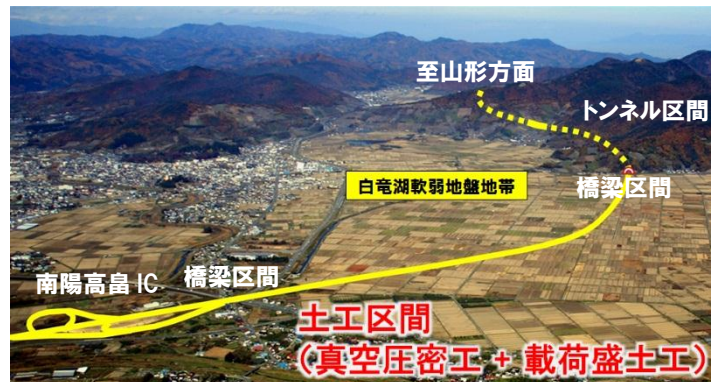
写真-1 現地状況写真
