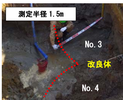
写真-1 改良体の出来形確認(1)
