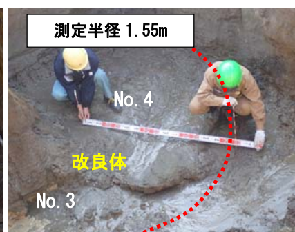
写真-2 改良体の出来形確認(2)
