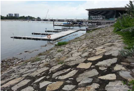
写真－1 河川護岸
