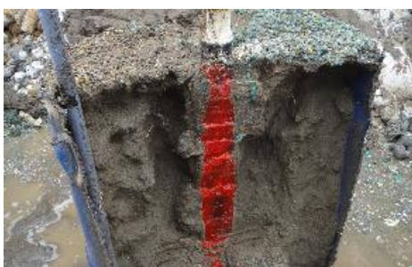
図5 固化後スリーブグラウト
