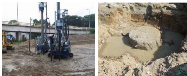
写真1 施工時の状況
