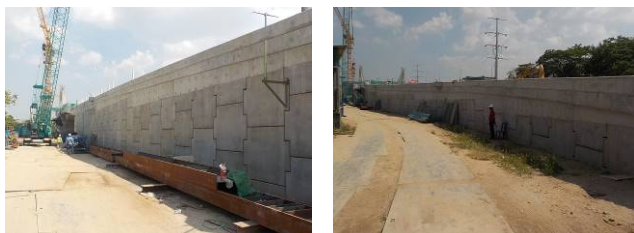
写真2 補強土壁面の状況
