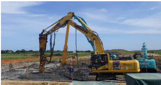
写真 1 高深度改良機施工状況
