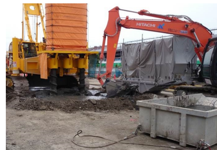
図-1 ベッセルへの排土投入状況
