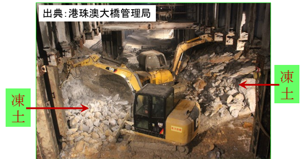
図-5 トンネル掘削状況
