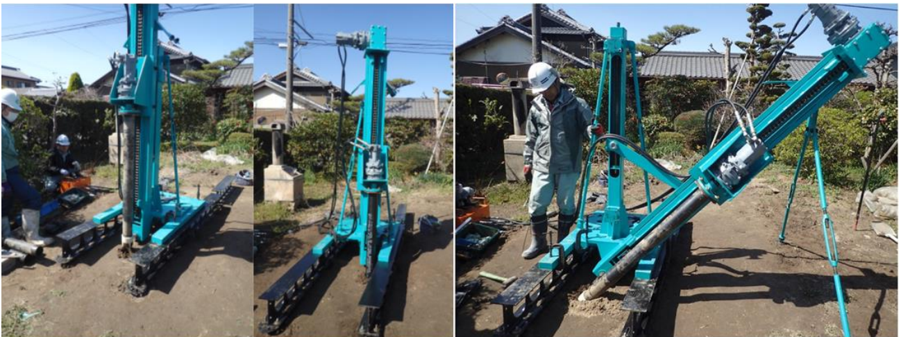
図-4 改良した低振動低騒音型回転圧入装置（左：検証実験状況、中央：首振り鉛直施工、右：斜め施工）
