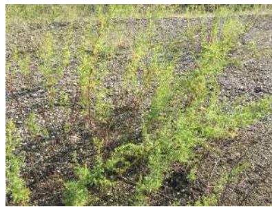
写真-2 盛土での植物生育状況
