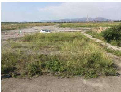
写真-1 カルシア改質土盛土
