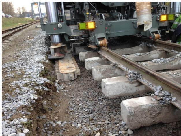
写真② アンダーカッターの挿入
