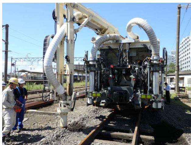
写真① マニピレーターによる作業
