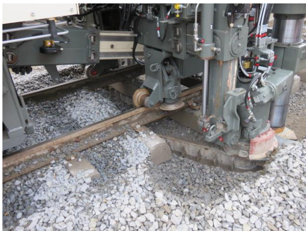
写真③ まくらぎ下面掘削状況
