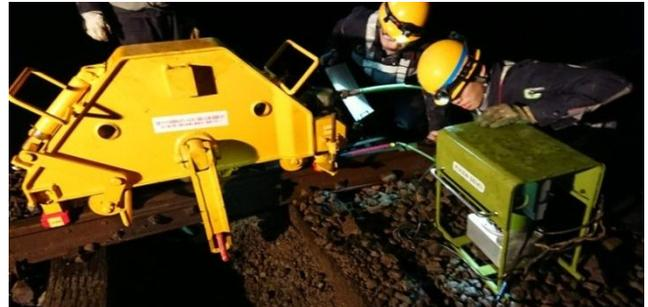
図1. 継目落ち整正器
