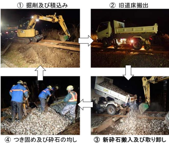
写真-1 現在の施工方法のサイクル
