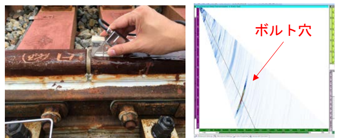
(a) 絶縁継目部の探傷状況
