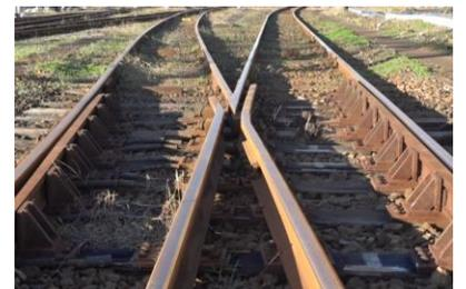
図3 外観(分岐線側開通時)
