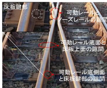
図4 隙間測定の概要
