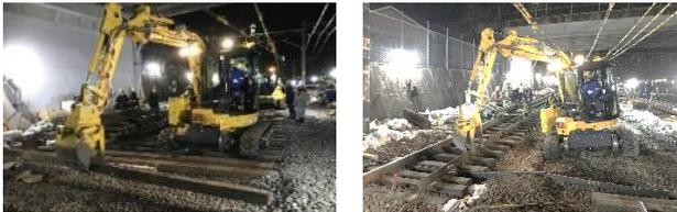
写真-2 分岐器撤去
