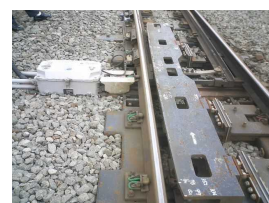
図11 2000形分岐器用ポイントガード全景
