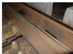
図1 車輪接触面(照り面)
