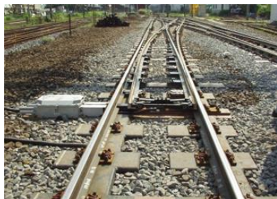
図1 2000型分岐器
