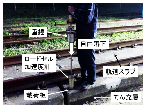
図 1 軌道スラブ上面における小型 FWD 試験の状況
