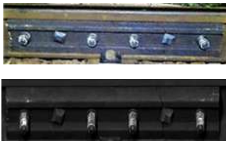
図1 継目板の現場仮設状況(上)と取得画像(下)
