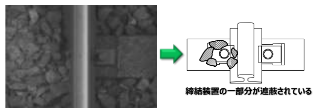
図2 締結装置不良箇所候補の例
