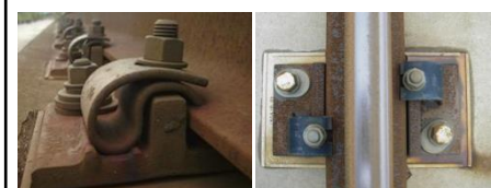
図-1 直結 8 型締結装置
