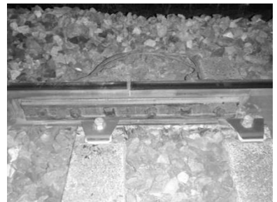
図-4 施工後の接合部
