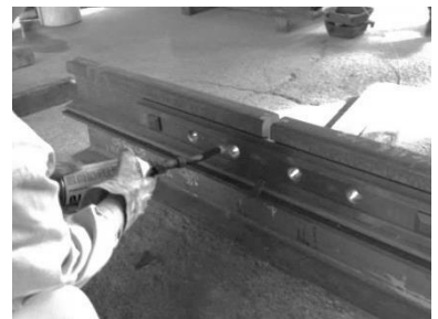
図-5 継目板表面の加熱
