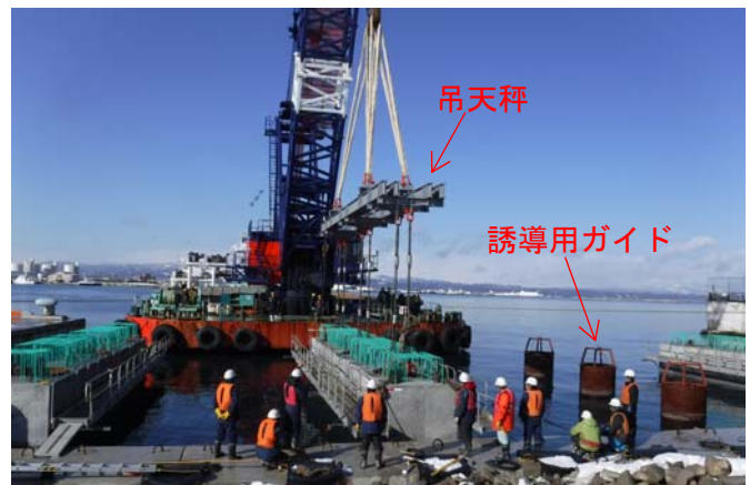
写真-2 プレキャスト受梁据付状況
