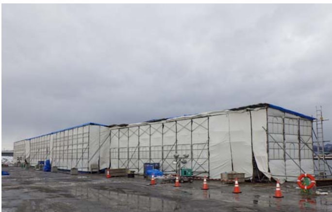
写真-1 プレキャスト受梁製作状況（雪寒仮囲）
