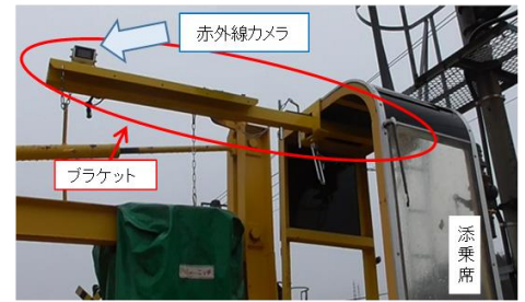
写真-2 ブラケット設置状況
