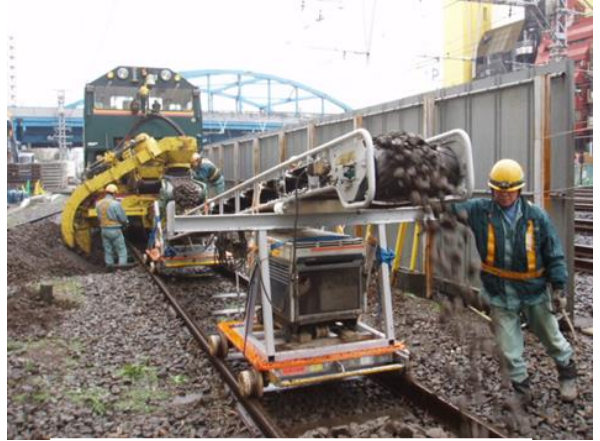
（図-3）道床バラスト前送り機構
