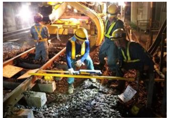
（図-4）軌道低下施工状況
