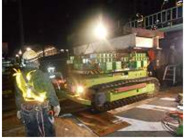
写真-2 既設桁搬出状況
