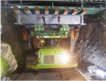
写真-3 新桁架設状況
