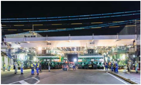
写真-2 既設桁撤去(上)と新設桁架設(下)の状況
