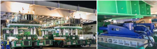
写真－1 多軸式特殊台車（左）とベント上ジャッキ（右）
