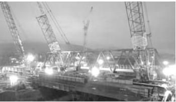
図-6 橋架設状況
