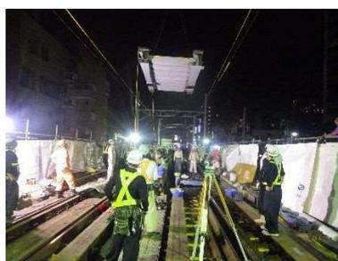
写真-2 工事桁架設状況
