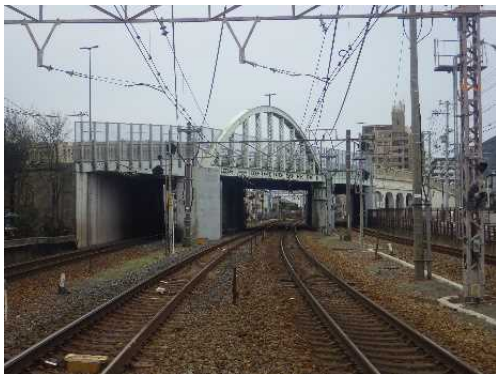
写真-1 こ線道路橋
