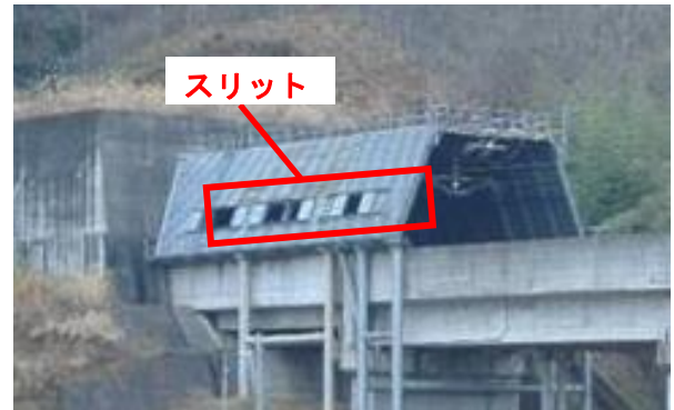
図-1 トンネル緩衝工全景
