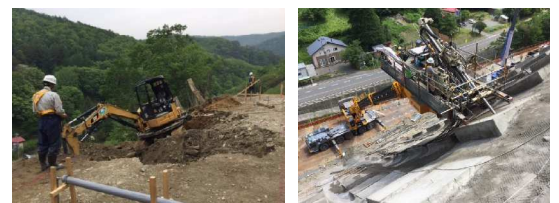
図-5 (左) クライミングバックホウ施工状況 (右) スカイステーション施工状況
