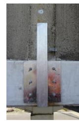
写真-4 試験施工
