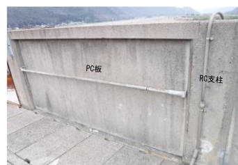
写真-1 RC 支柱式高欄
