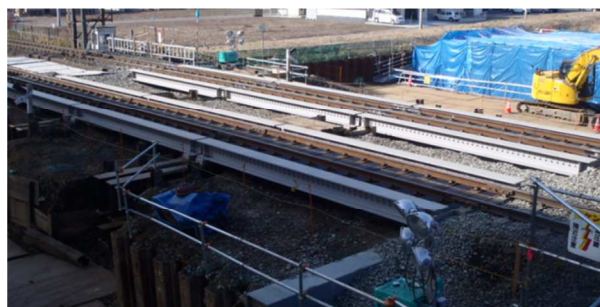
写真-1 鉄道用工事桁
