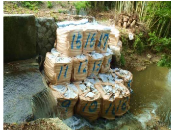
写真-4 大型土嚢設置
