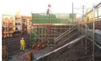
写真-2 単管足場
