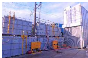
写真-3 プラント
