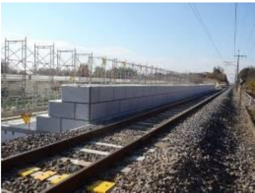
写真1 軽量盛土の施工状況
