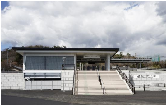
写真2 新駅完成状況
