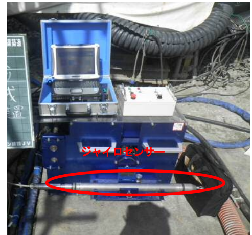
写真-3 孔曲り計測管理システム
