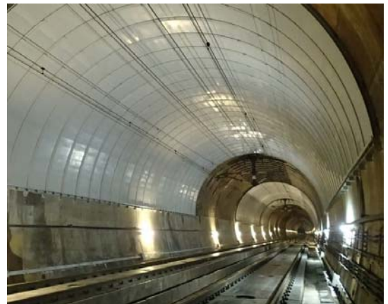
写真-2. FRP 内巻工 (完成時)
