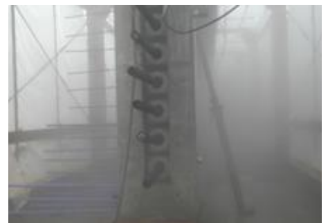
図-1 ミスト養生状況
