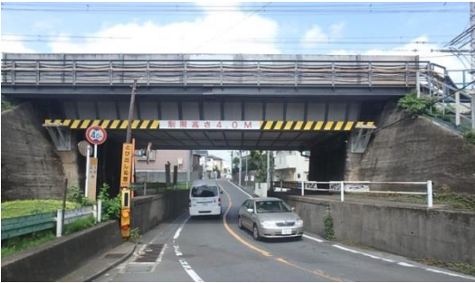
写真 1 旧恩田川橋梁（現況）
